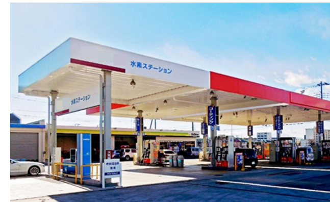
【水素ステーション】
